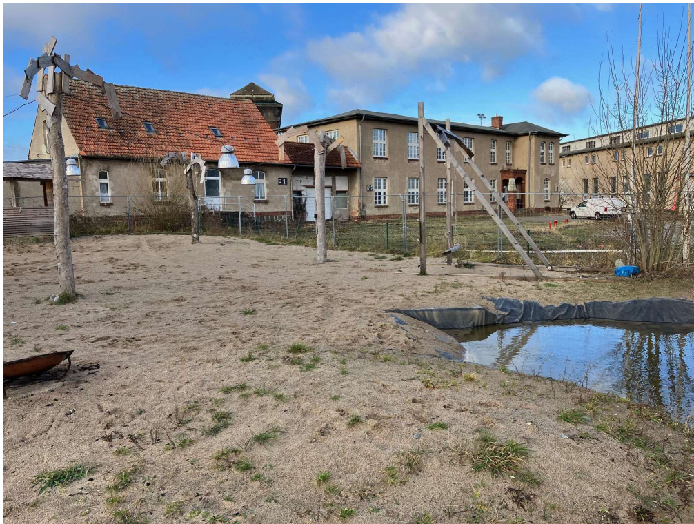
Abbildung 7: Bestandsbebauung im Plangebiet
